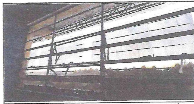
Foto 6: Cambio de ventanas por balcones por el peligro que se pueden quebrar los vidrios.
