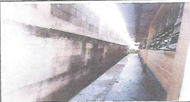
Foto 3: Las paredes de los muros se encuentran afectadas por la lluvia que cae directamente en las paredes, provocando humedad.
